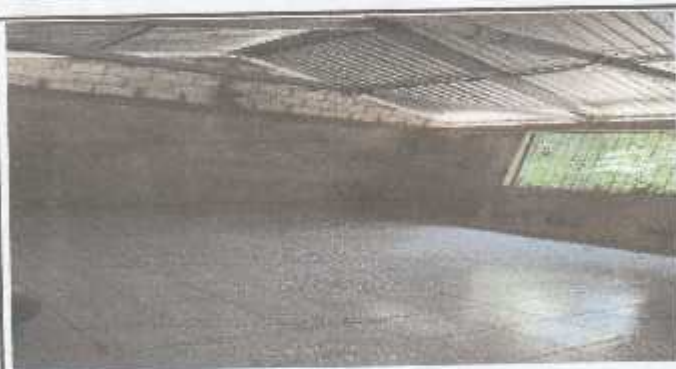
Foto 3: LOS MOGINETES YA CAMBIADO TABLA POR BLOCK
