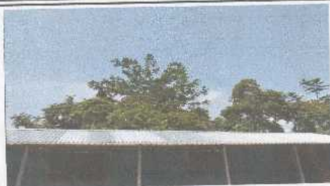
Foto 1: ASÍ QUEDO EL TECHO FINALIZADO DE TELESECUNDARIA.
